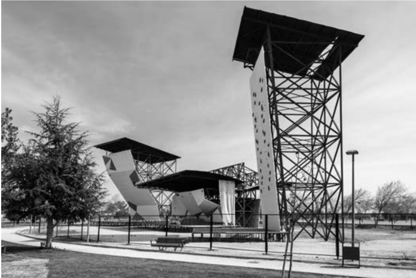
Muro de escalada. Registro fotográfico Serviu RM.
